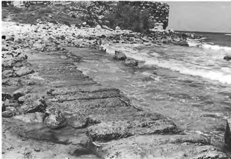
רציף בנמל הפניקי בעתלית בנוי נדבכי ראשים, סאה ו לפנה"ס Quay built of headers in the Phoenician harbor at Athlit, 6th century BCE.
